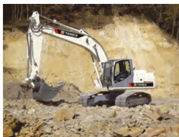
Экскаватор выкапывает яму.
